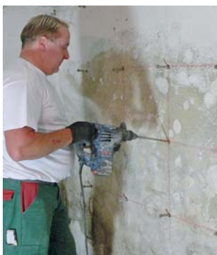
Vorbereitung zum Injizieren der Silikonharzlösung. Foto: veinal.de/akz-o
