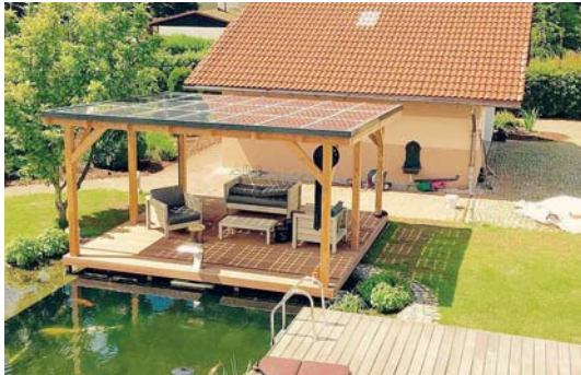
Jedes Solardach wird individuell geplant, passend zum Architekturstil des Eigenheims und den örtlichen Platzverhältnissen.
