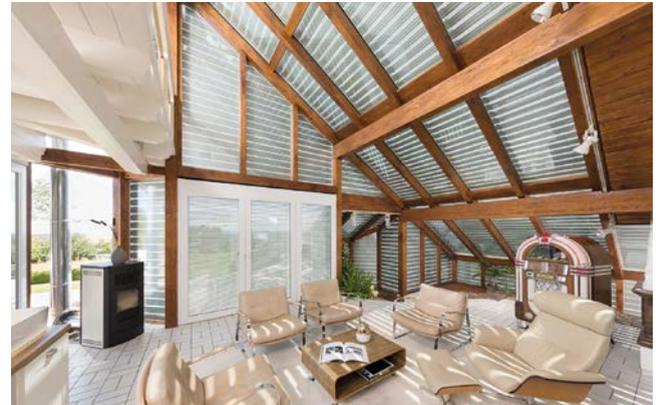
Es gibt inzwischen auch Rollläden mit Lichtschienen, die selbst im geschlossenen Zustand noch gesundes Tageslicht einfallen lassen. Foto: djd/Schanz Rollladensysteme
