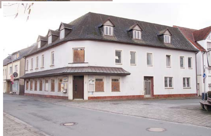
Das Haus Lange Straße 16 kommt bald unter die Abrissbirne.
