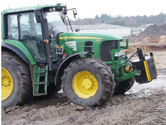
Am künftigen Standort der Brauerei sind Baumaschinen aktiv. Fotos: Herbert Gruber
