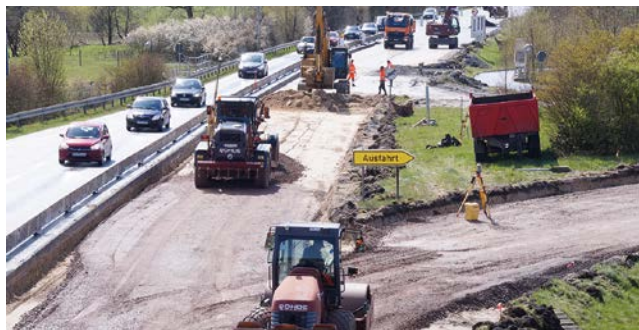
Im Bereich der Talle herrscht reges Treiben an der zurzeit bedeutendsten Straßenbaustelle im Kreis Paderborn. Foto: Herbert Gruber
