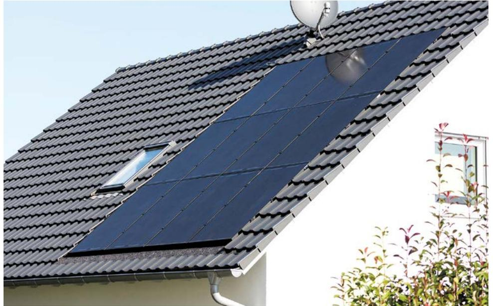
Eine perfekte Kombination: Statt herkömmlicher Aufdach-Kollektoren sind diese Photovoltaikmodule in die Dachfläche integriert. Wer mit dem damit gewonnenen Strom eine Wärmepumpe antreibt, um sein Haus zu heizen, macht sich unabhängiger von Energielieferanten - und hilft der Umwelt. Der Staat unterstützt derartige Maßnahmen finanziell sehr deutlich. tnx. Foto: Creaton/txn
