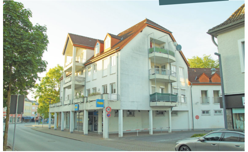
Das heutige Ladengeschäft mit darüber liegenden Wohnungen kennzeichnet sich durch zweckmäßige Beton-Optik. Die Schönheit liegt im Auge des Betrachters. Foto: Herbert Gruber / Heimatverein
