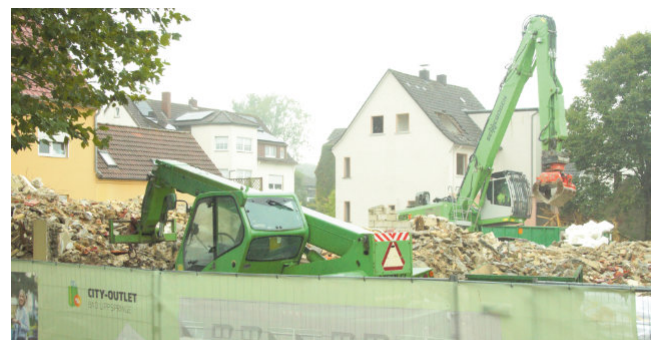
Der Abriss der Gebäude in der Arminiusstraße läuft derzeit auf Hochtouren. Fotos: Herbert Gruber
