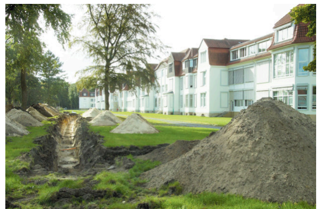
Ein langer Graben soll die isolierten Nahwärmeleitungen aufnehmen. Fotos: Herbert Gruber
